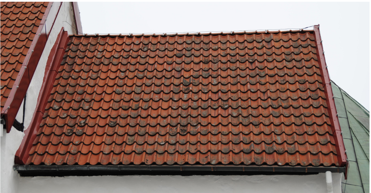
Kortaket mot söder efter renovering.
