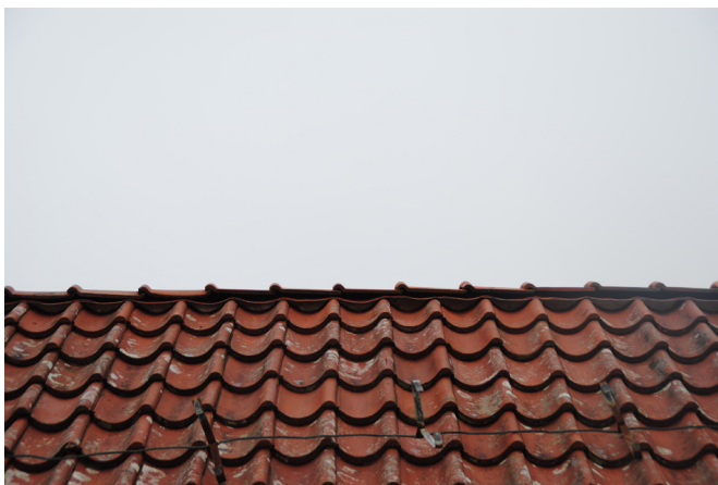
Undernockpannorna har ett nockband lagts för tätning och nockpannorna har skruvats fast i nockbrädan.
