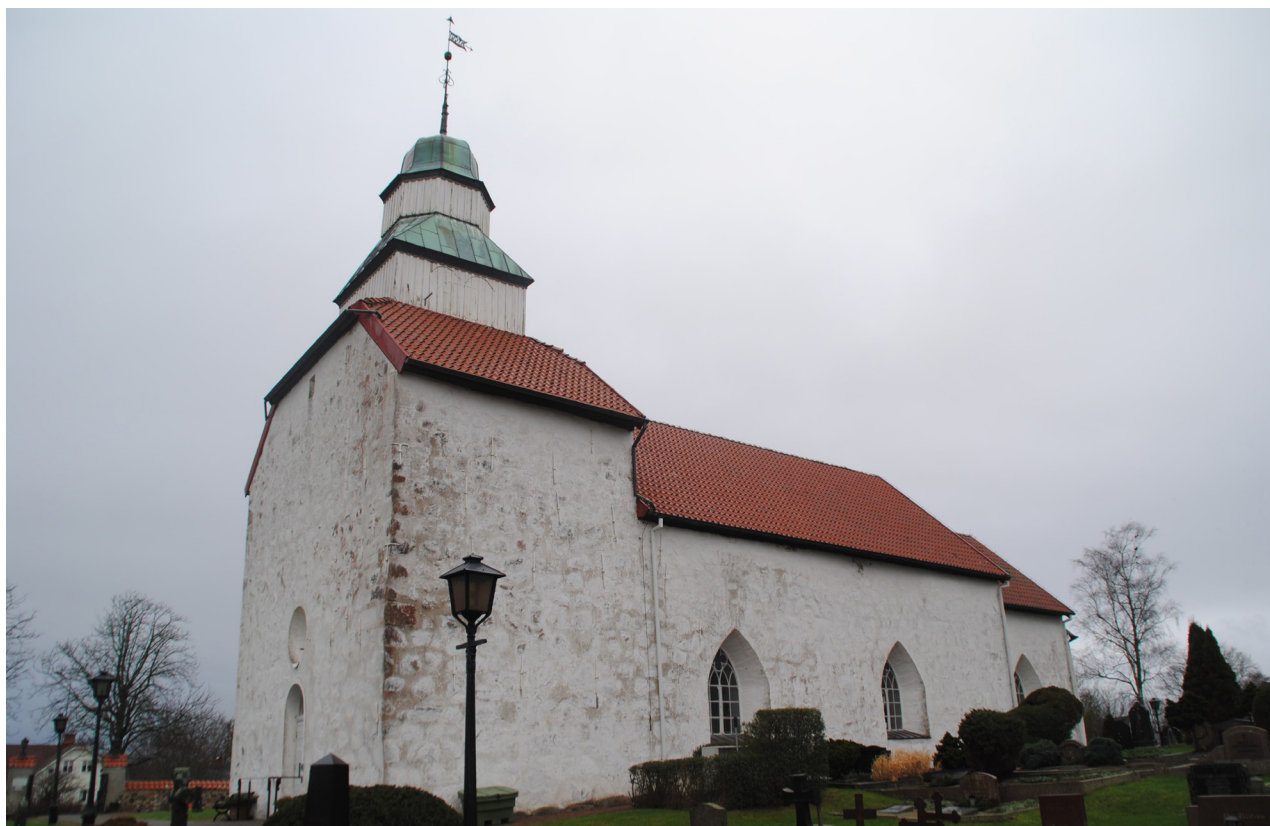
Fasaden på tornets västra och södra sida, samt fasaden på långhusets södra sida var missfärgade av alger.
