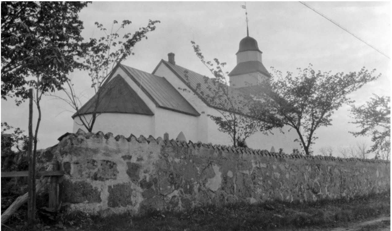
Äldre fotografi där det listtäckta papptaket syns på kor- och långhustak. Foto från RAÄ, Kulturmiljöbild.
