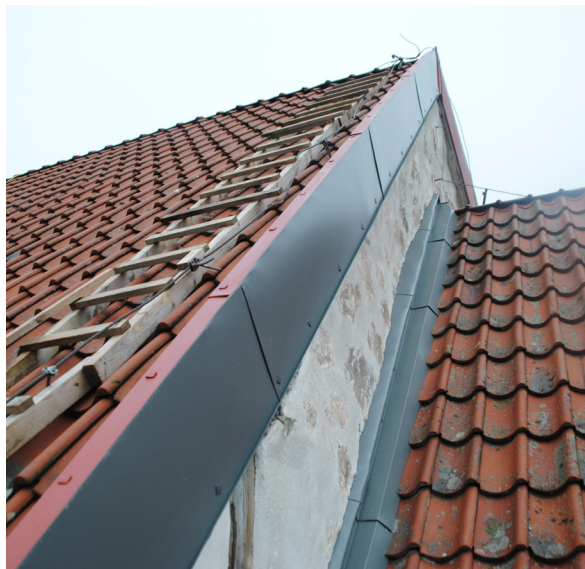
Ny vindskiva mot öster på långhustaket och ny stånskiva på kortaket mot gavelröset på långhuset.
