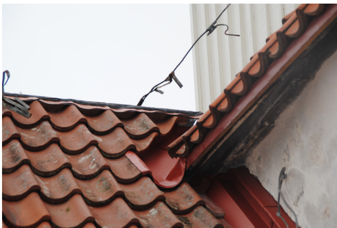
Skarven mellan långhustaket och det lilla taket mot öster på tornet.
