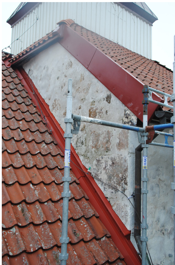
Ny stånskiva på långhustaket mot tornväggen. All galvad plåt har målats i engelskt röd kulör.
