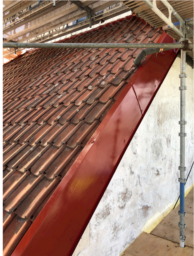
Vindskivorna av plåt efter montering och målning med Beckers metall täckfärg.
