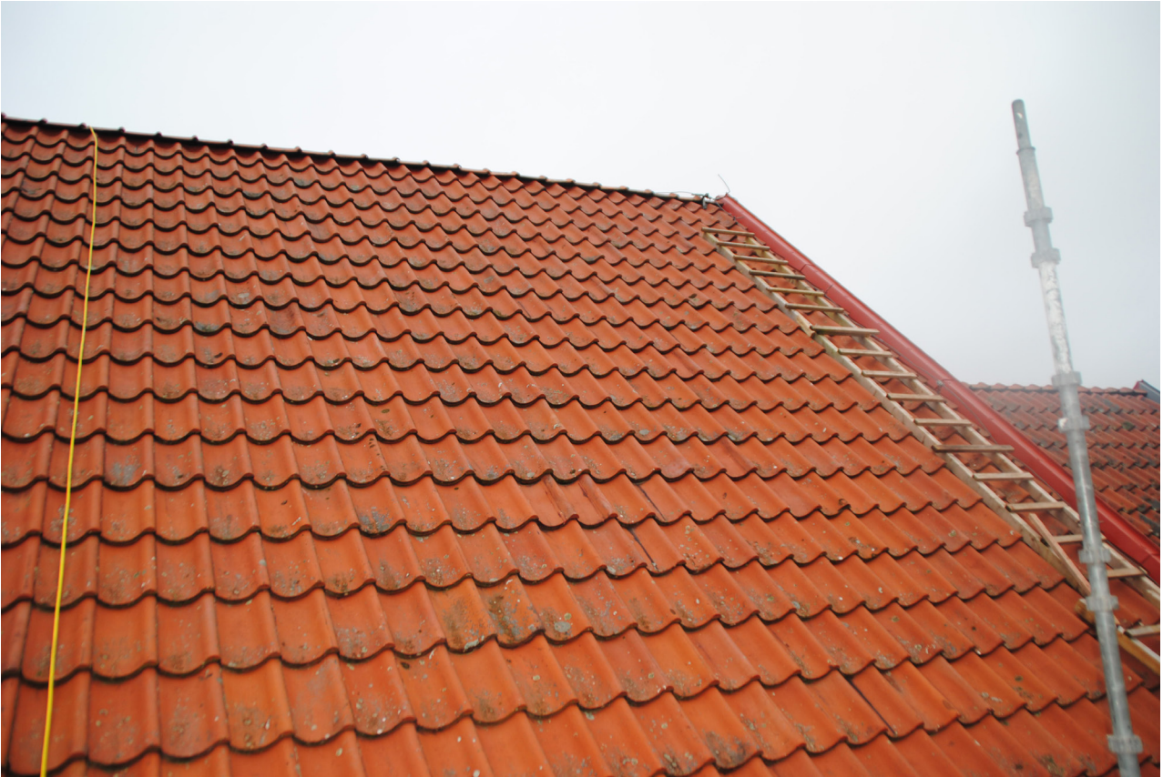
Långhustaket på södra sidan efter renovering.
