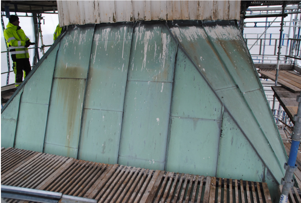
Nedre torntaket av kopparplåt
