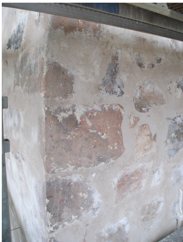
Fasaderna på tornet efter att ytorna har blästrats. Den mesta av färgen gick bort medan själva putsen inte påverkats i någon högre grad.
