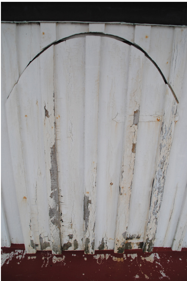
Gångjärn och beslag på tornluckorna är ålderdomliga och var i behov av rostskyddsbehandling och ommålning.
