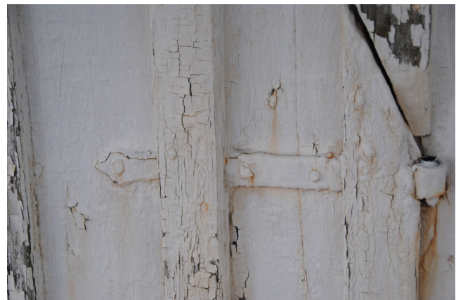
Gångjärn och beslag på tornluckorna är ålderdomliga och var i behov av rostskyddsbehandling och ommålning.
